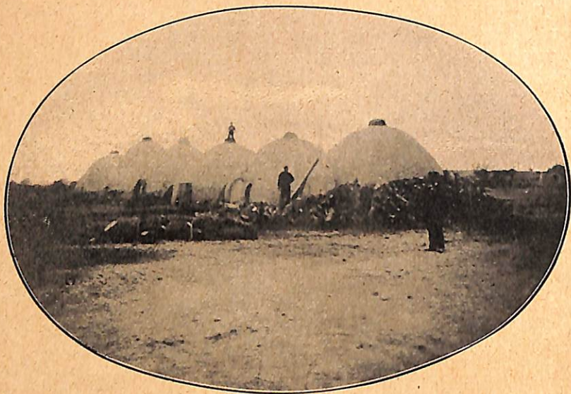
LA INDUSTRIA DEL QUEBRACHO BLANCO EN EL NORTE DE CÓRDOBA.—HORNOS DE CARBÓN DE LEÑA EN CRUZ DEL EJE
