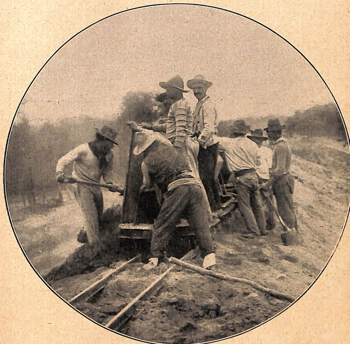
EL TRABAJO FERROVIARIO DE LOS CRIOLLOS. — PEONADAS EN LA QUEBRADA DE HUMAHUACA CONSTRUYENDO UN TERRAPLÉN EN LA LÍNEA DE PERICO Á LEDESMA
